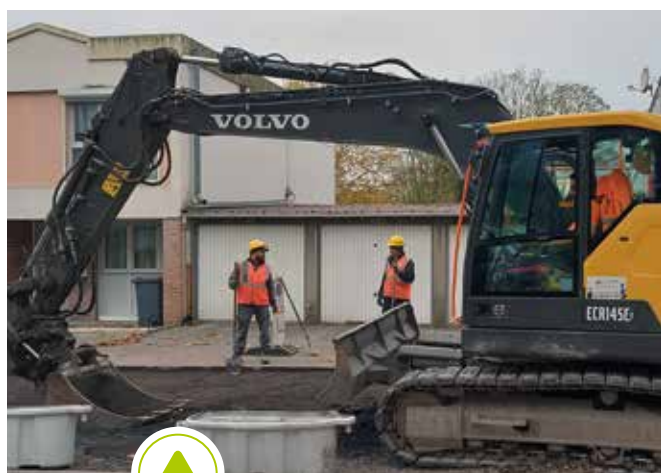
Intervention sur les conditions de travail dans l'entreprise Jean Lefebvre Nord
