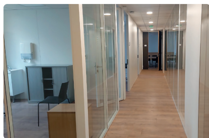
Travaux d'agrandissement au centre d'Hallennes-lez-Haubourdin
