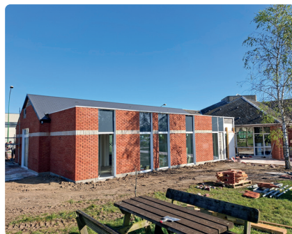
Travaux d'extension au centre de Leers
